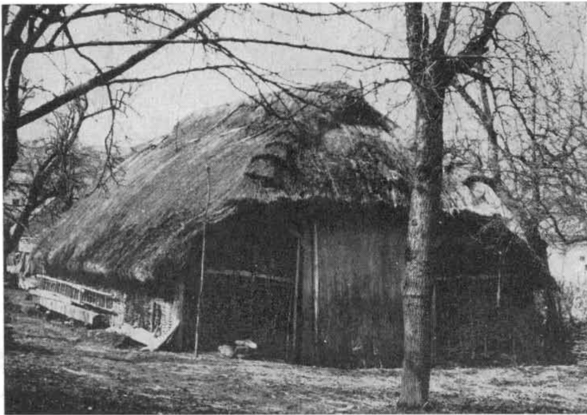
Obr. 29. Stodola stĺpikovej a rámovej konštrukcie s vypletanými stenami v Závade, okr. Topoľčany, prvá pol. 20. stor.
