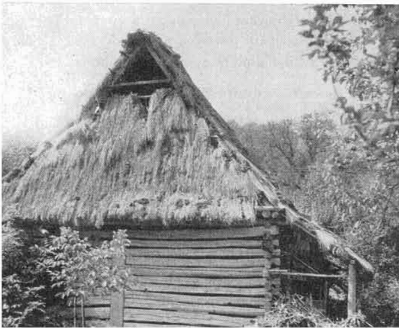
Obr. 16. Žliabková technika použitá na stene stodoly v Brádne, okr. Rim. Sobota, koniec 19. stor.
