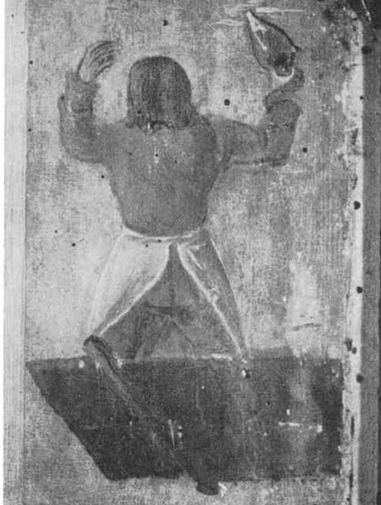
Obr. 20. Murárske nástroje (kelňa a lešenie) používané pri omietaní kostola, severné Slovensko, zač. 16. stor.
