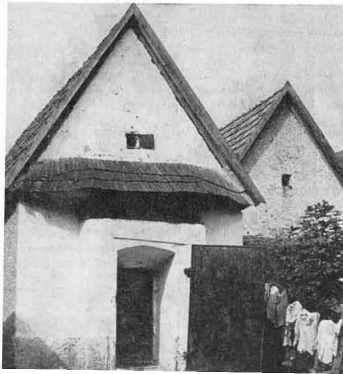
Obr. 25. Murovaná sýpka so železnými okenicami a dvercami v Podhradí, okr. Martin, koniec 19. stor.
