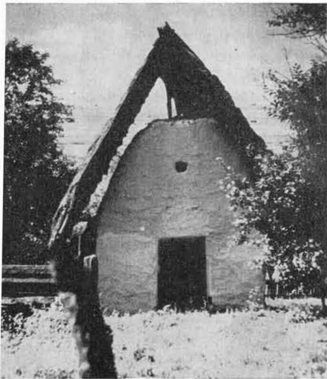
Obr. 24. Zrubová omazaná sýpka s voľne nasadenou strechou v Beňadikovciach, okr. Bardejov, prvá pol. 20. stor.
