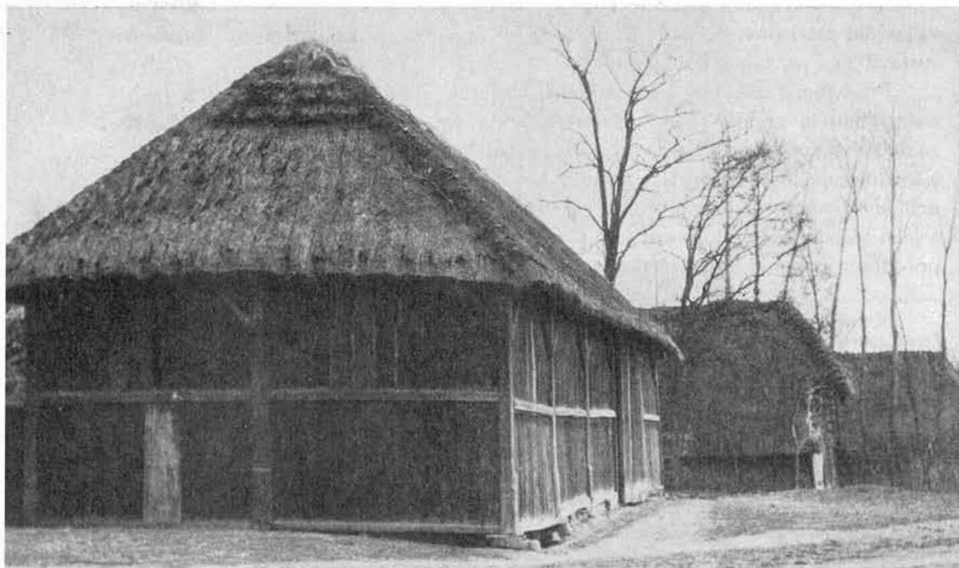
Obr. 31. Stodola stĺpikovej a rámovej konštrukcie s doštenými stenami v Kátove, okr. Senica, prvá polovica 20. stor.
